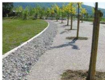
Tranchée recouverte Source : Symasol
