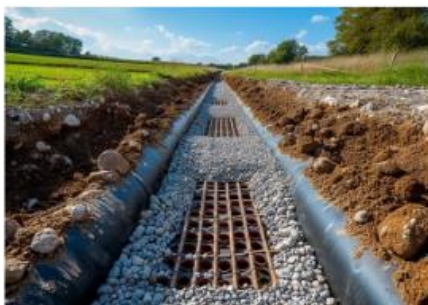
Tranchée drainante en construction Source : Les activateurs
