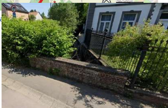
Figure 16 : Hain vu de la Rue de la Gare
