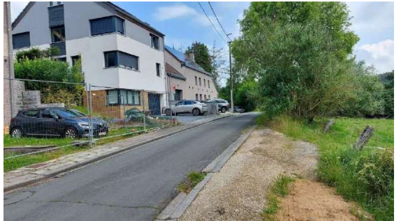
Figure 17 : Rue de la Fontaine
