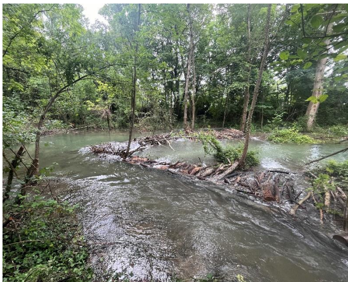
Figure 18 : Ouvrage castor situé le plus en aval sur la Lierne
