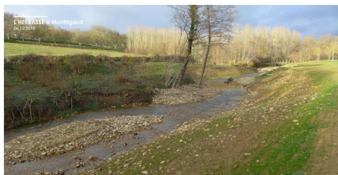
Figure 17 : Une partie du linéaire de l'Herbasse restaurée, après travaux (BIOTEC, 2024)
