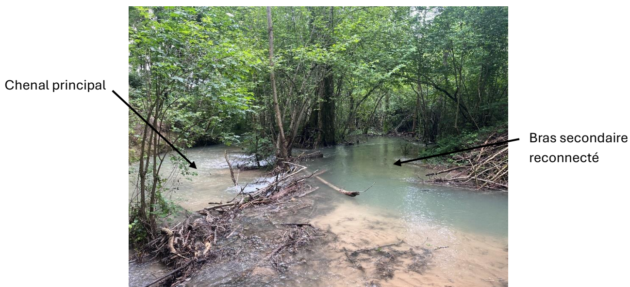
Figure 20 : Second ouvrage, situé plus en amont sur la Lierne
