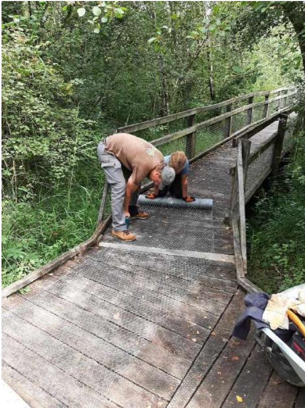
Figure 17 et 18 : Pose du grillage anti-dérapant sur le pilotis
