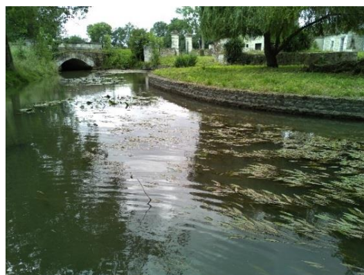
Figure 43 : Zone de potamots en aval de l'ouvrage
