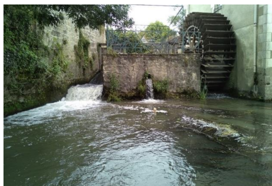
Figure 39 : Déversoir du bras du moulin
