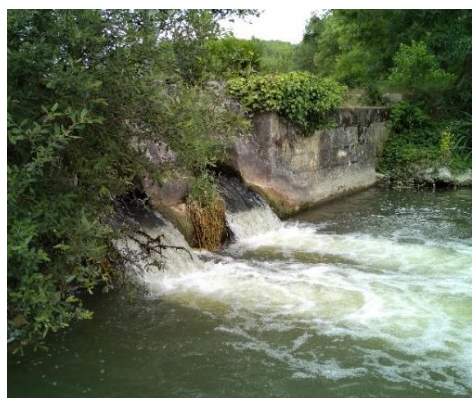
Figure 42: Chute d'eau du seuil du bras de décharge du moulin de la Boussaye
