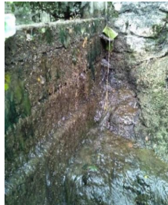
Figure 36 : Rugosité des parois du seuil du bras de décharge aval du Moulin de Saint-Gilles
