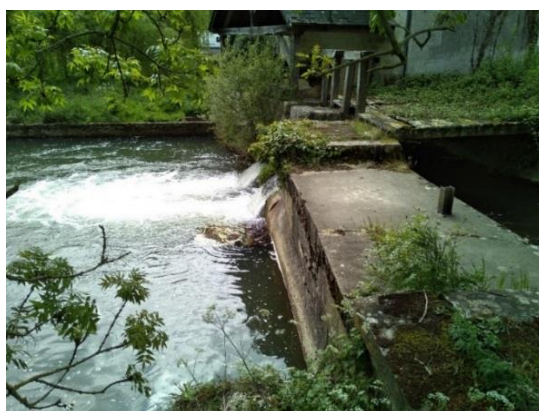
Figure 44 : Seuil du bras de décharge du moulin de la Boussaye
