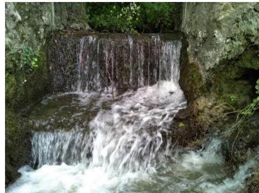
Figure 38: Déversoir du bras de décharge amont du moulin de Saint-Gilles
