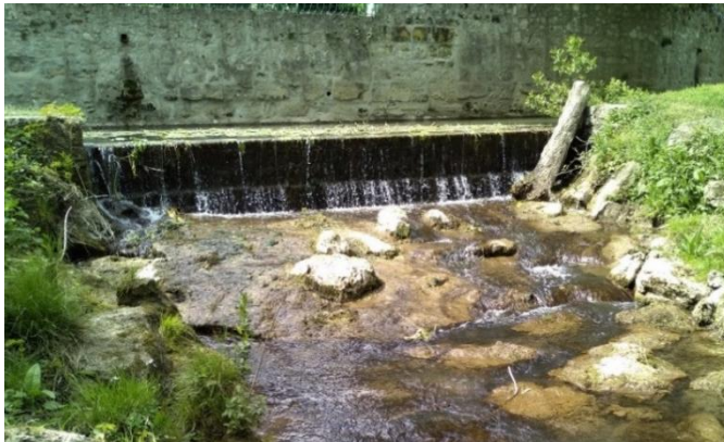
Figure 35: Seuil du bras de décharge aval du Moulin de Saint-Gilles
