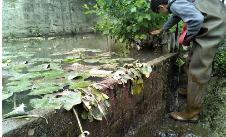
Figure 25: Hauteur d'eau atteinte (main de l'opérateur) au seuil du bras de décharge aval du moulin de Saint-Gilles, lors de la crue de Vienne du 23/06/2024
