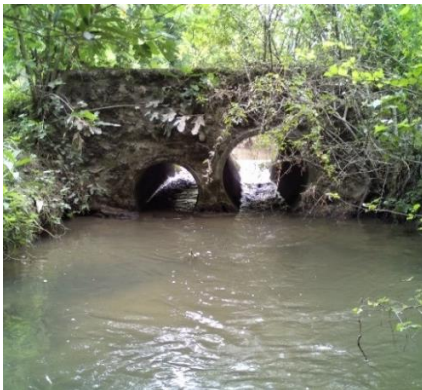
Figure 37 : Pont busé du bras de décharge amont du Moulin de Saint-Gilles
