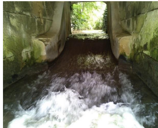
Figure 46 : Passage de roue en rive droite du Grand Moulin
