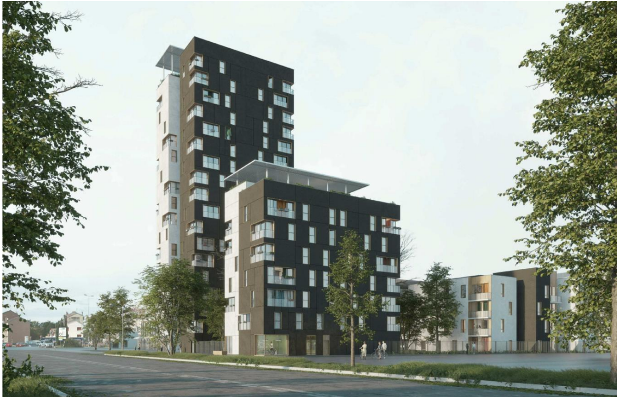
Fig. 13 : Tour Elithis à Vandoeuvre-les-Nancy, par le cabinet SCAU Architecture Source : Catella
