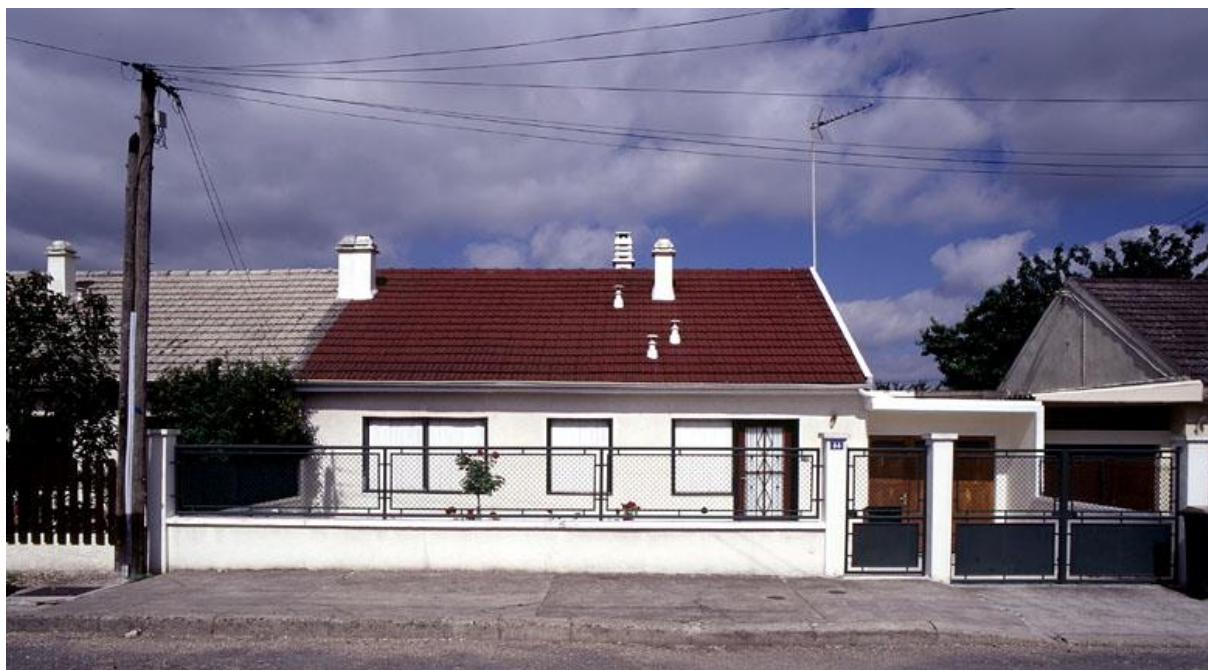
Fig. 17 : Exemple d'une maison phénix de 1955 « Les Castors de Richeville » à Conflans-Sainte-Honorine (78) Source : POP (plateforme ouverte du patrimoine) – Ministère de la culture
