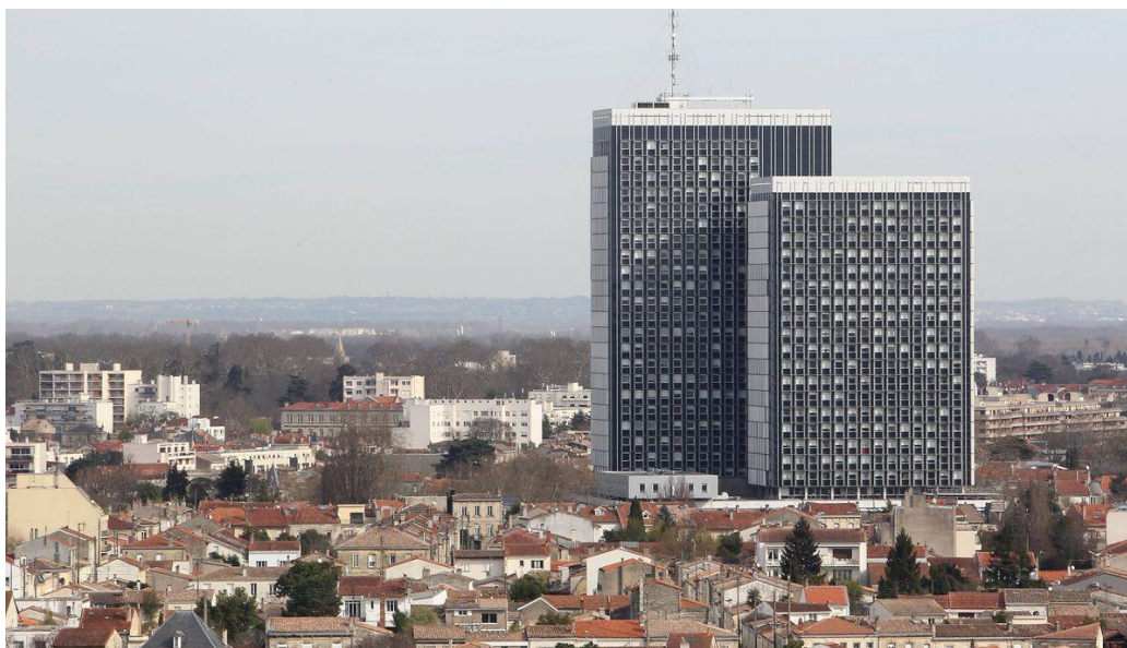
Fig. 3 : Cité administrative de Bordeaux, recevant 47,5 millions d’euros pour sa rénovation,
