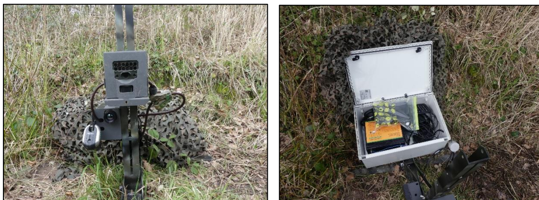
Figure 15 : Installation de la caméra thermique sur le support à gauche. Batterie et ordinateur stockés dans le boîtier étanche à droite. (M. Olivier)
