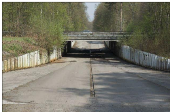
Figure 3 : Passage inférieur de la drève de Bassy, vu en direction du nord. (Cerema, 2018)
