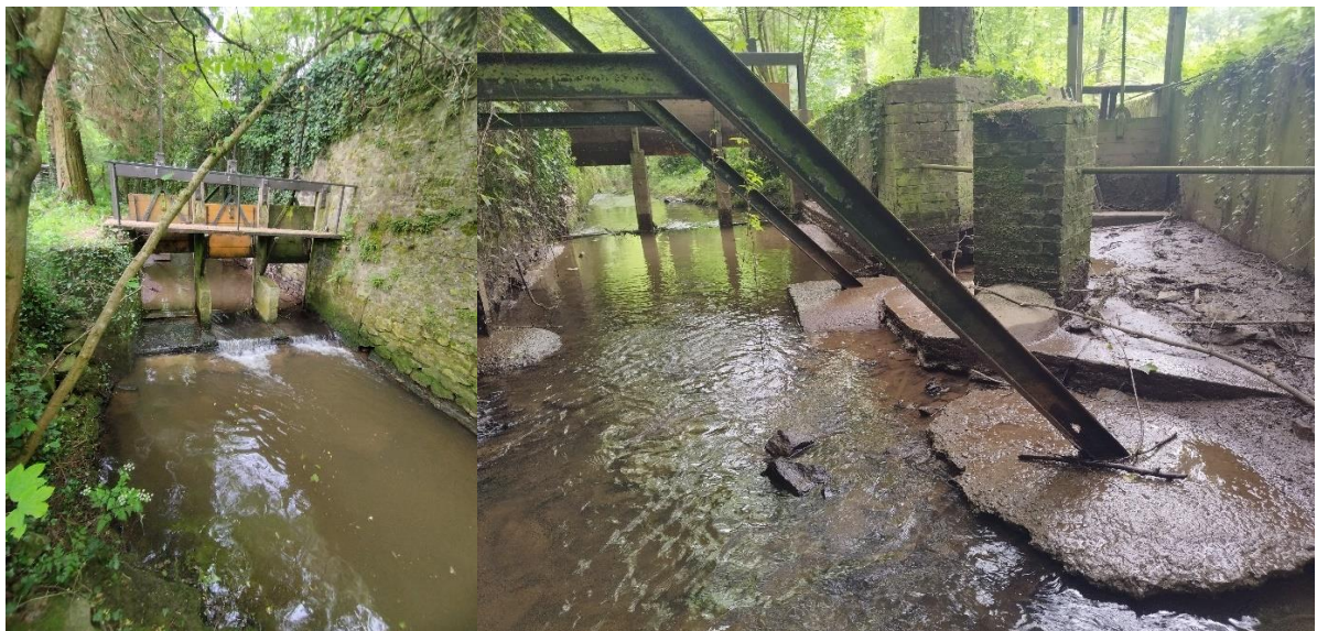
Figure 23 : Respectivement vue vers l'amont et vue vers l'aval de l'ouvrage de partage
