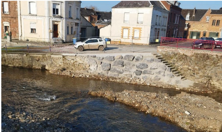
Figure 13 : la réparation du mur nécessitait mesure de profil en travers pour calcul du gabarit hydraulique.
