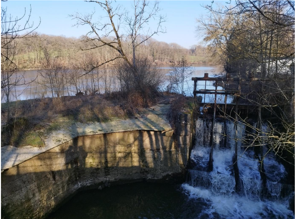
Figure 5 : Fin de digue ainsi que vannes de l'étang du Pas-Bayard
