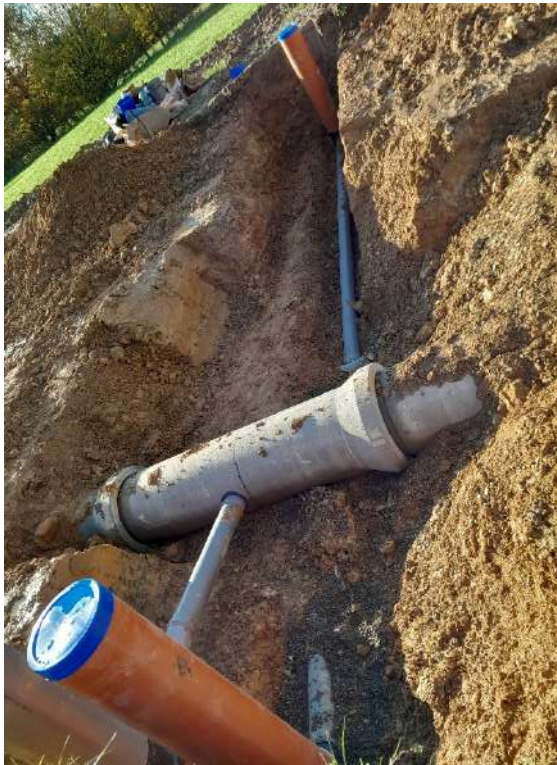
Figure 31 : Pose de réseaux EP/EU (Source : Mrabet Salima)
