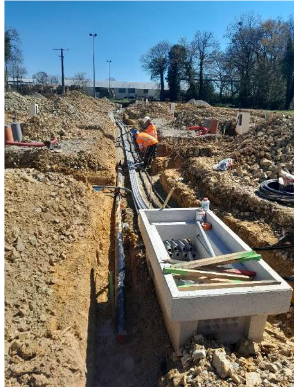
Figure 30: Pose de réseau télécom (Source : Mrabet Salima)
