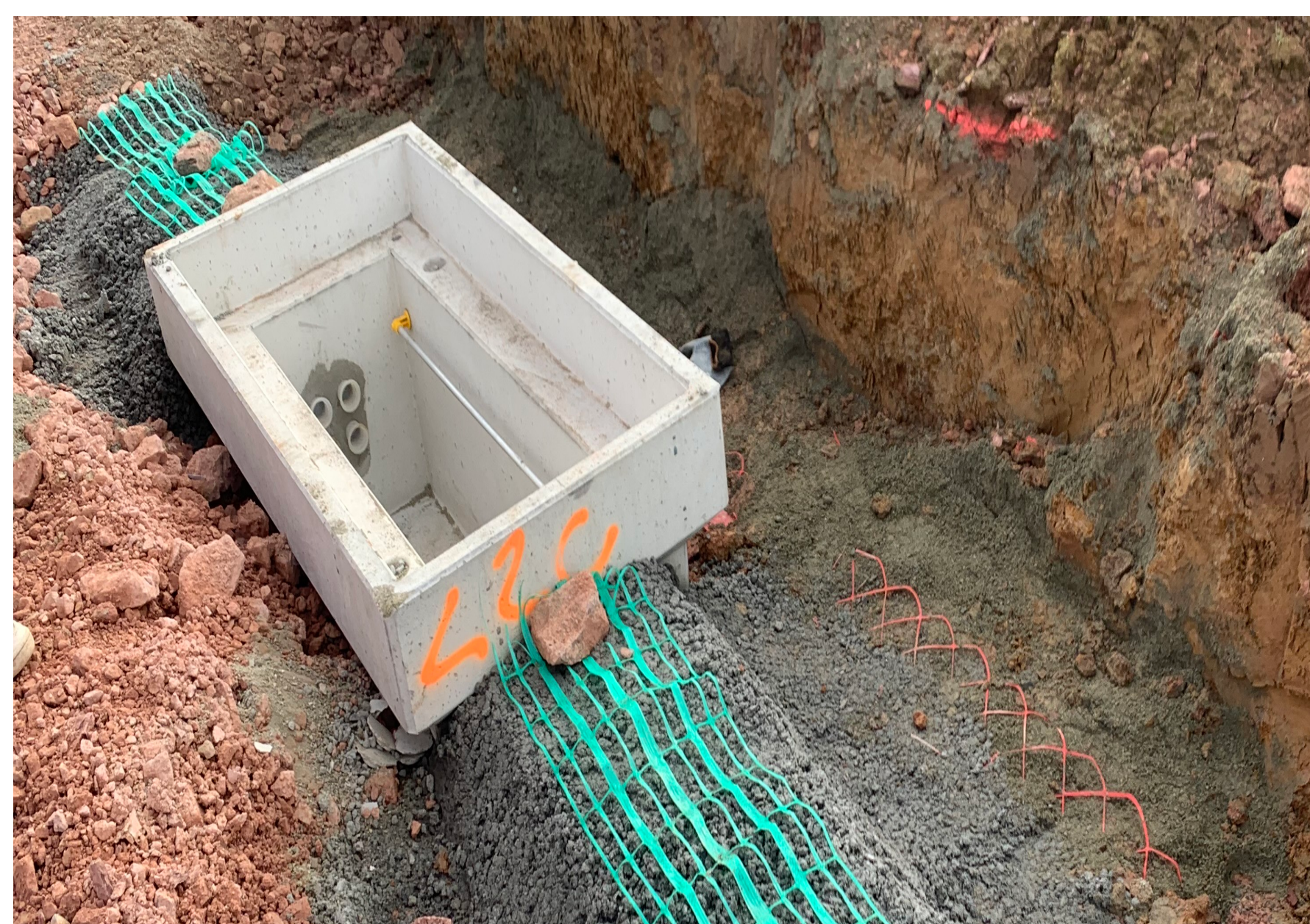
Pose d'une chambre Télécom
