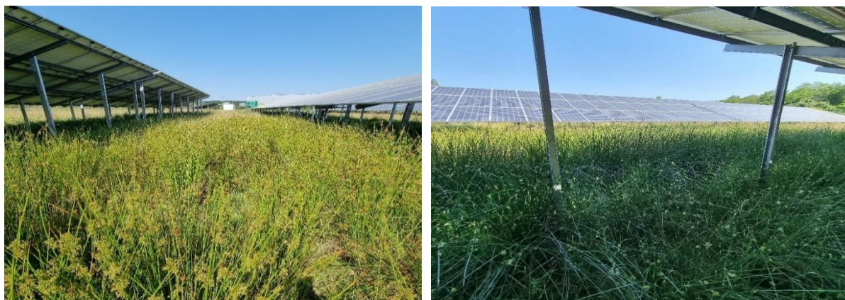
Figure 8 : Jonchaie entre et sous les panneaux du parc du Vieux Domaine (THEMA Environnement, 2023)
