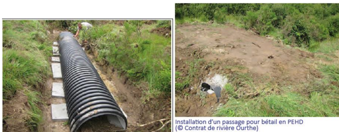
Figure 25 : Passage pour bétail en PolyEthylène Haute Densité (Source : Contrat de rivière Ourthe)
