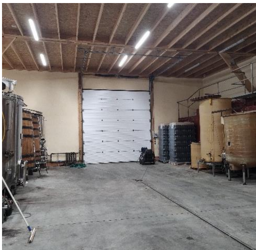
Figure 6 : Intérieur du chai du domaine du Mortier (côté ouvert sud)
