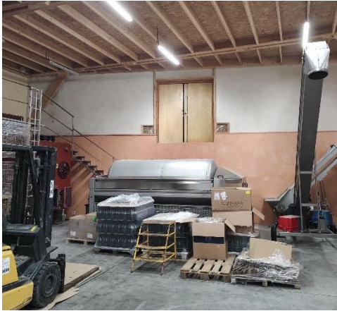
Figure 7 : Intérieur du chai du domaine du Mortier (côté semi-enterré Nord)
