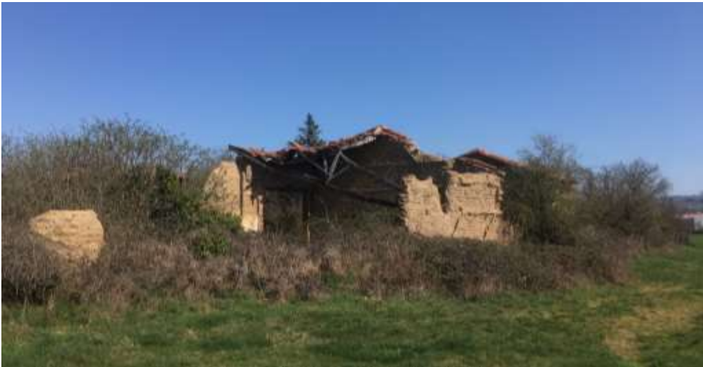
Figure 48 : Ferme en ruine (Soberco Environnement, 2023)
