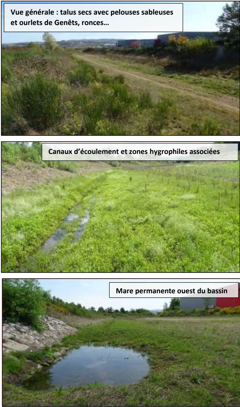
Figure 19 : Photographies du bassin d'orage, (Soberco Environnement, 2022)
