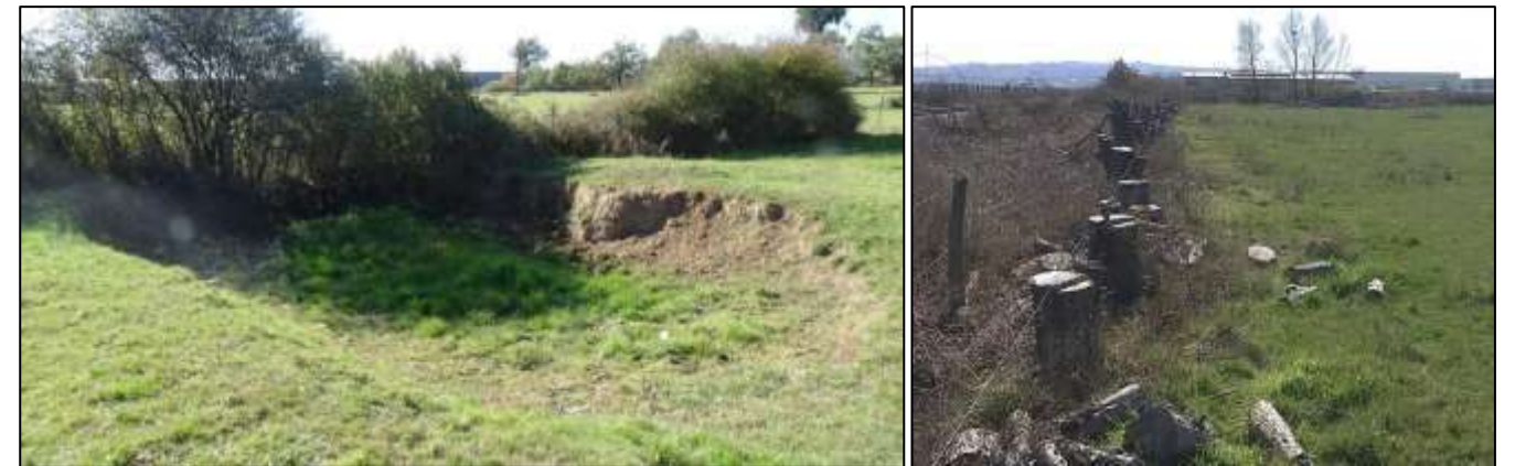
Figure 14 : Mare asséchée et ancienne haie de résineux (Soberco Environnement, 2021)
