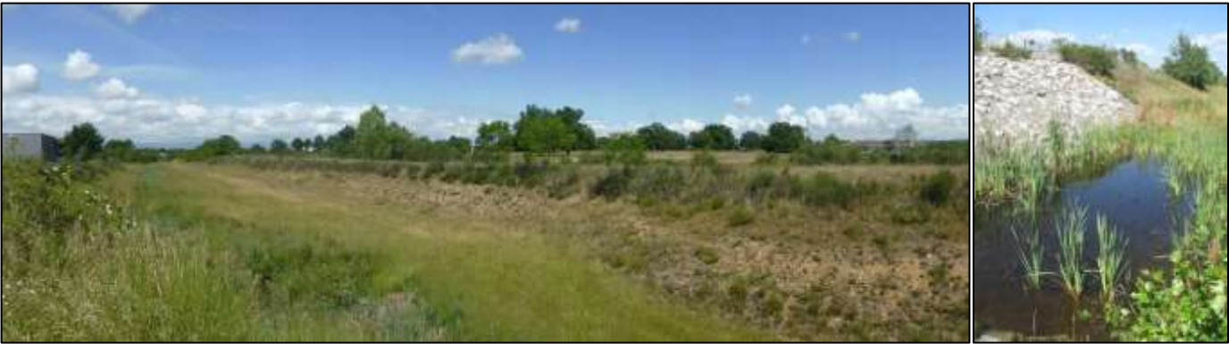
Figure 4 : Bassin de rétention (à gauche) au Sud du site et de la partie principalement inondée (à droite) à l’Ouest de l’ouvrage. Photos prises sur site (mai 2014, juillet 2014). Sources (de gauche à droite) : Soberco Environnement et O. Benoit Gonin – Oxalis.
