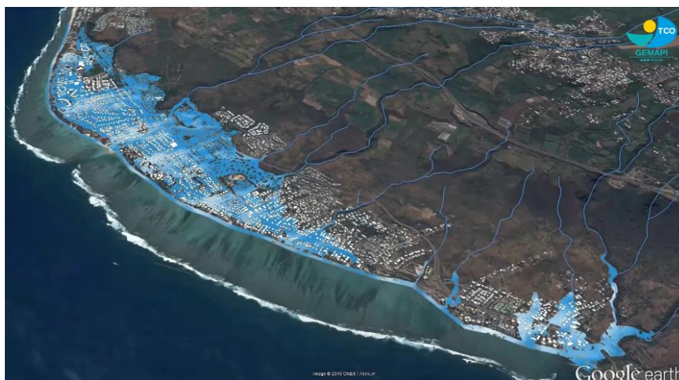
Figure 5 : Modélisation d'une crue centennale sur le secteur de l'Hermitage/La Saline Source : TCO, 2023, tco.re, https://www.tco.re/gemapi/la-gepi/papi/papi-hermitage/
