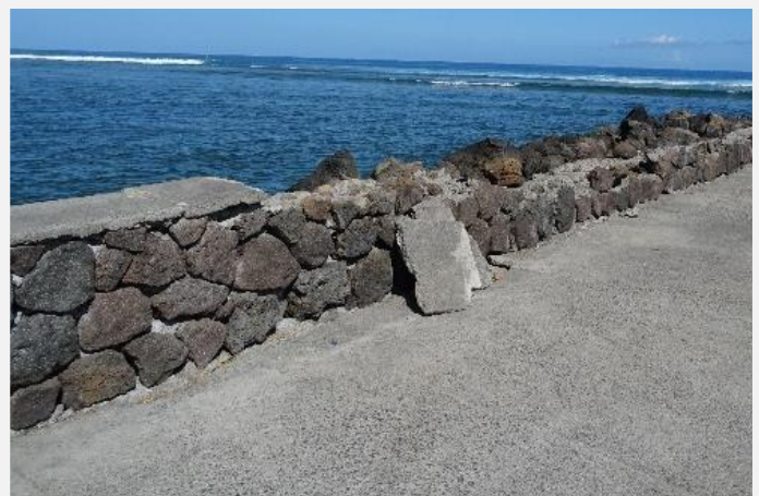
Digue principale du port de Saint-Leu (source : phase I)
