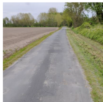
Route secondaire en bon état
