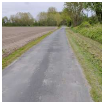
Route secondaire en bon état
