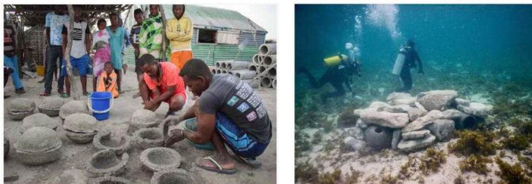
Figure 16 : Montage et installation des habitats en bommies (source : Reef Doctor)
