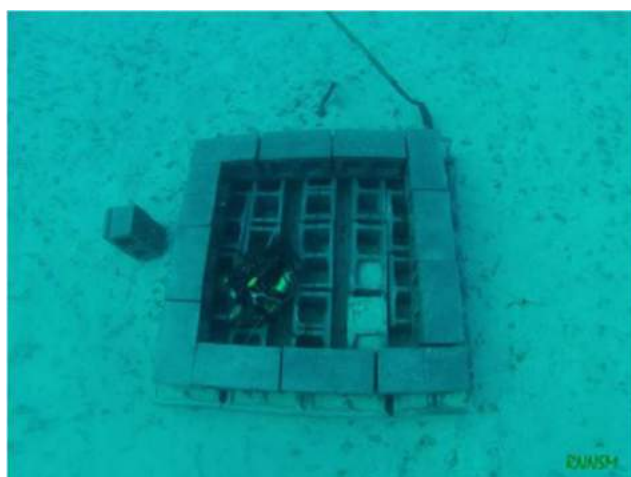
Figure 29 : Assemblage des parpaings emplis de sédiments constituant la base du module (Chalifour, 2014)
