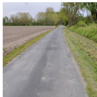
Route secondaire en bon état
