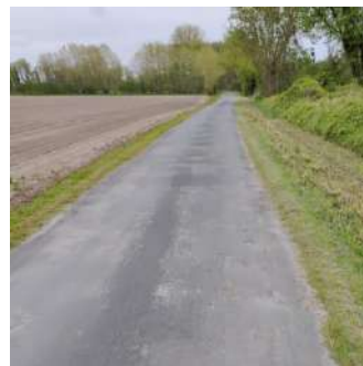
Route secondaire en bon état
