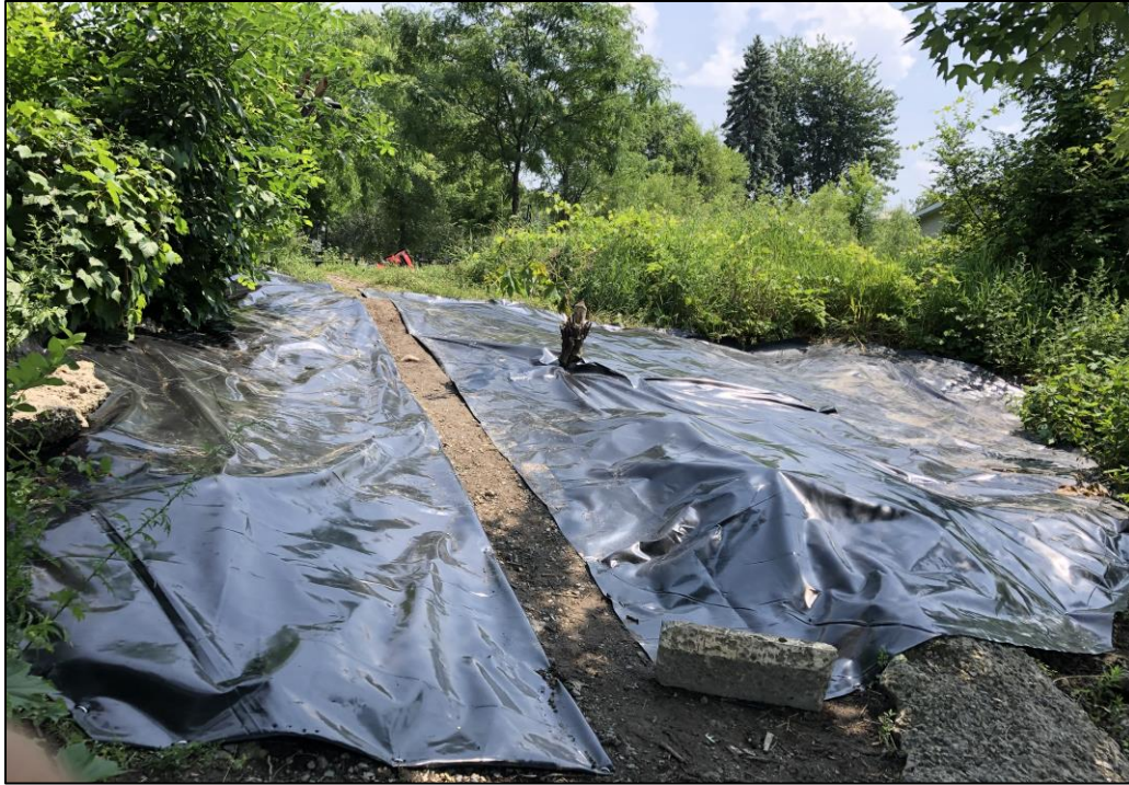
Figure 10: Installation finalisée de la géomembrane (@Mathias Moison)
