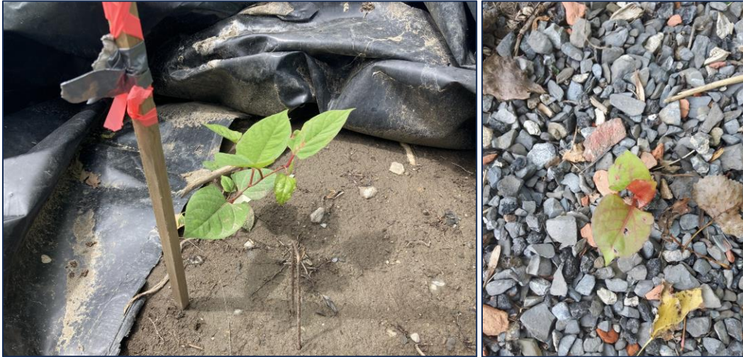
Figure 15 : Exemples de petite repousse constatée au bas de la géomembrane (@Mathias Moison)
