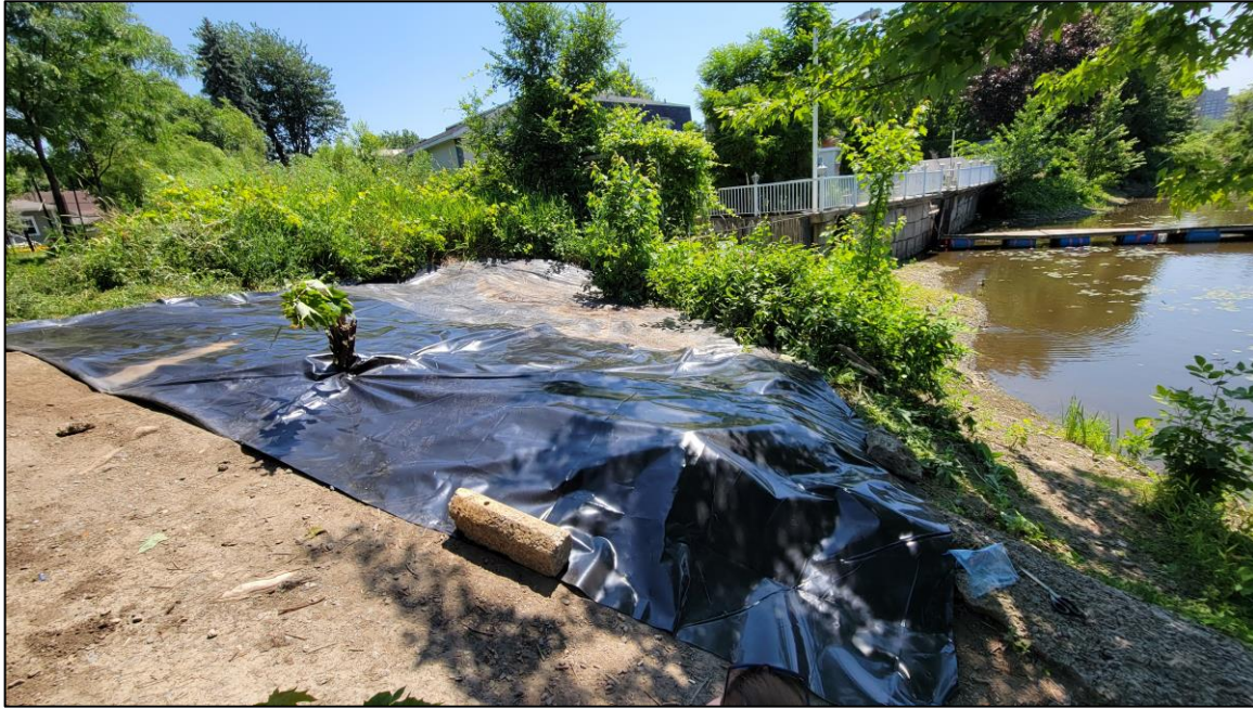
Figure 9: Nouvelle géomembrane (gris foncé) juxtaposée à l'ancienne géomembrane (gris clair) (@Mathias Moison)
