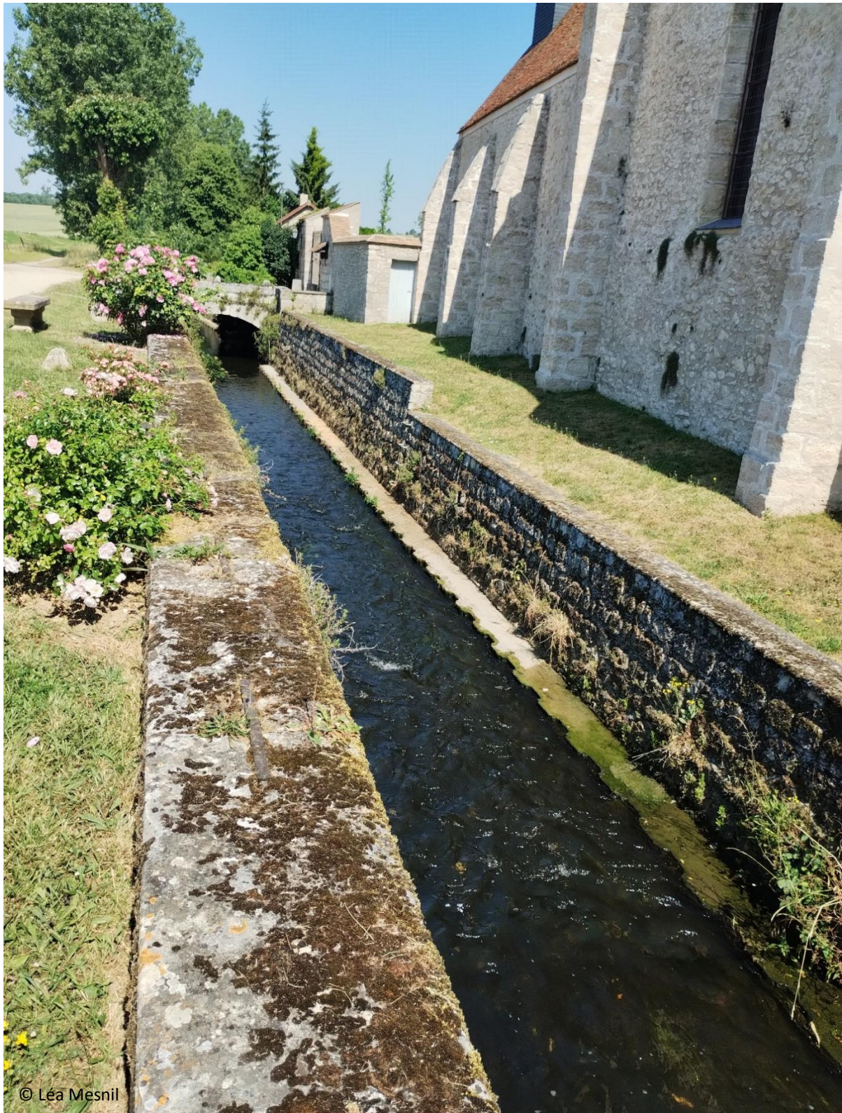
Figure 10 : Cours d'eau rectiligne en milieu urbain, berges maçonnées et présence de palplanches
