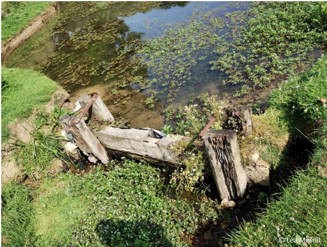
Figure 7 : Ouvrage situé sur le cours d'eau utilisé pour la création d'un plan d'eau en amont
