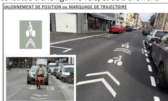
Figure 20 : photographies et illustration d'un jalonnement de position constitué comme souvent d'une figurine vélo, et de 2 chevrons. Source :
