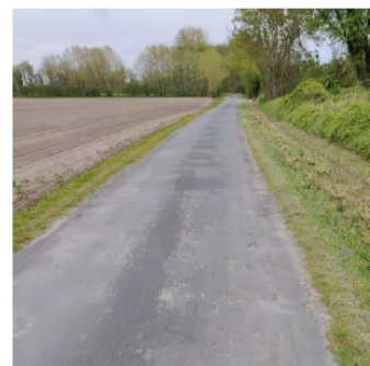
Route secondaire en bon état
