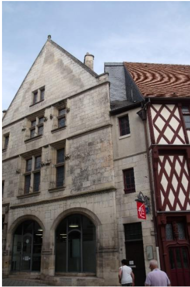
Figures 23 et 24, A gauche : devanture en feuillure s'intégrant bien au sein de sa façade, contrairement à celle de droite, qui présente une devanture en applique (source : Hugo Le Squer, photographies personnelles)
