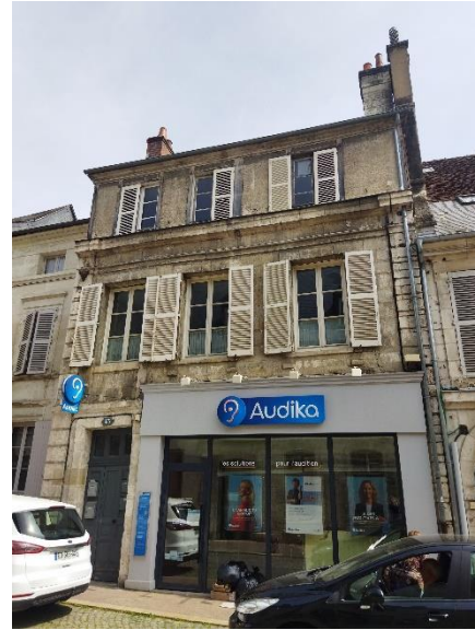
Figures 23 et 24, A gauche : devanture en feuillure s'intégrant bien au sein de sa façade, contrairement à celle de droite, qui présente une devanture en applique (source : Hugo Le Squer, photographies personnelles)
