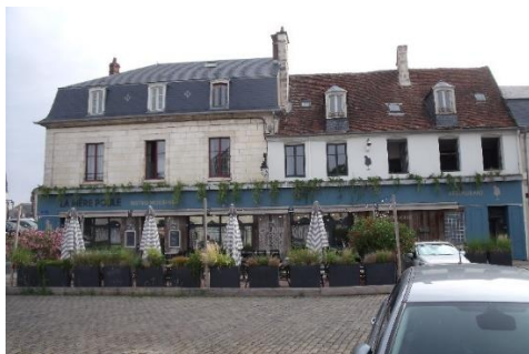
28 rue des Cordeliers, mauvaise intégration due au non-respect du rythme parcellaire
