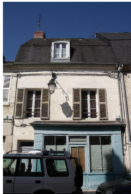
19 rue des Cordeliers, devanture en applique dont l'aspect et le caractère assez ancien pourrait justifier d'un intérêt, malgré une mauvaise intégration au sein de la façade
