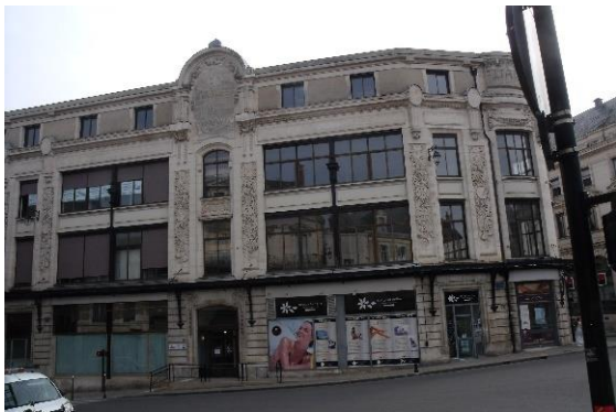
2 Place Plachat, devanture commerciale en feuillure remarquable, caractérisée par son intégration au sein d'une façade présentant un intérêt patrimonial
