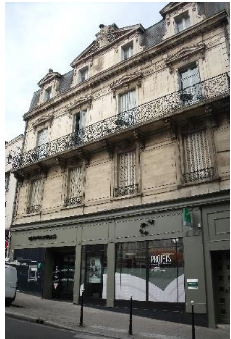
13 Place Planchat, maison bourgeoise, repérée au sein du psmv, présentant de très riches ornements en pierre, un balcon en fer forgé comportant également des ornements
