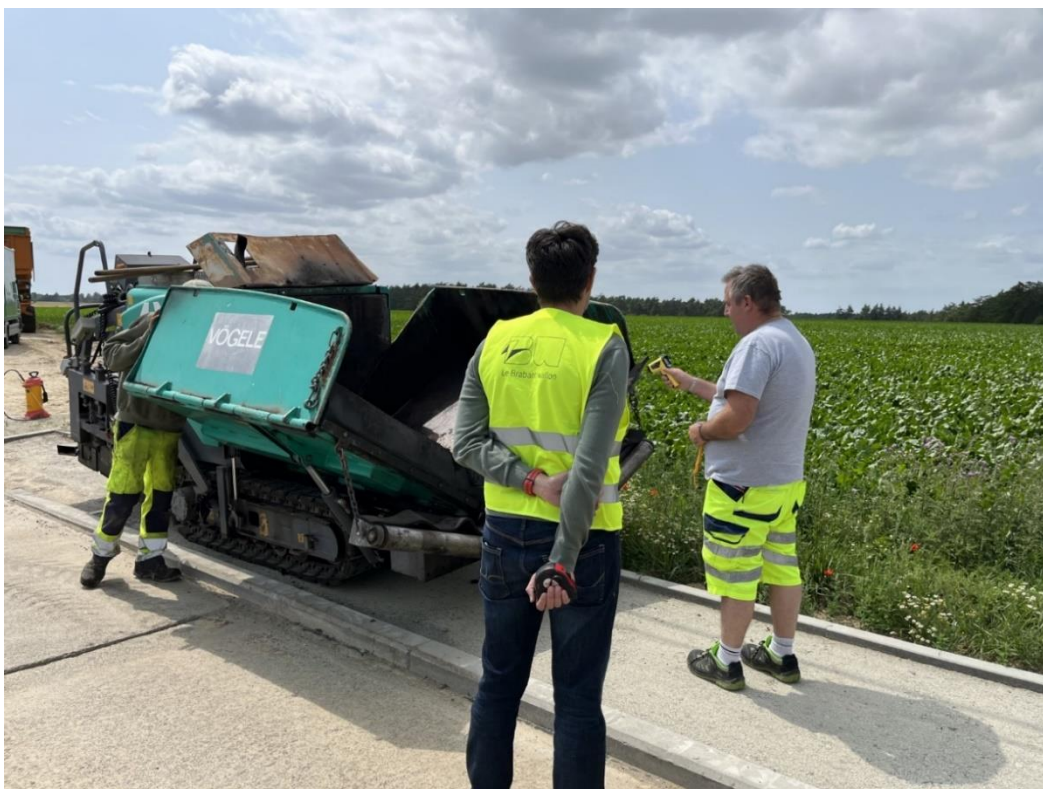
Fig.28, Emmanuel Haegeman et le responsable travaux de Villers-La-Ville vérifiant la qualité de l'asphalte, source : Corentin Jacquet
