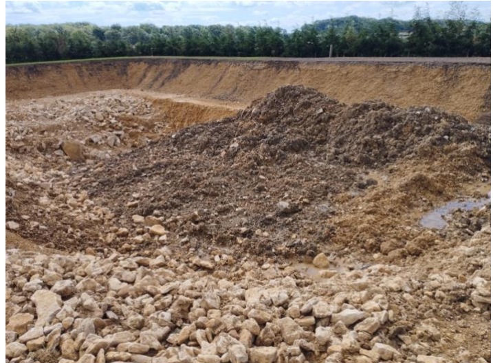
Figure 10 : Réservoir d'eau naturelle en construction
