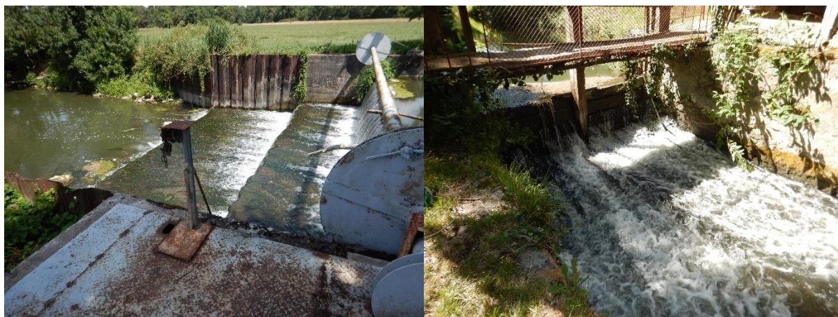
Figure 27: Illustrations du clapet des Vallées (à gauche) et du radier du Moulin de la Marche (à droite).
