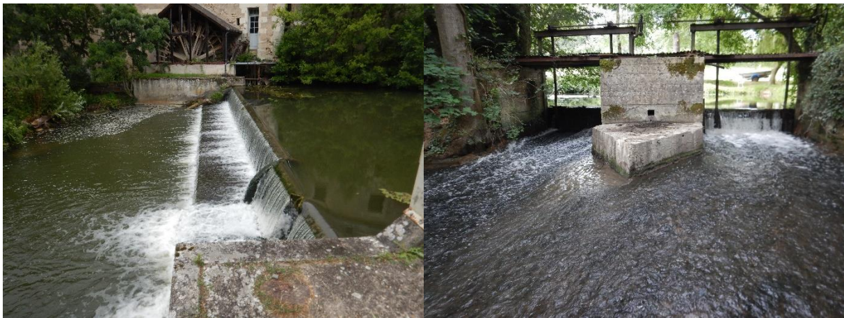
Figure 16: Illustrations du clapet du Moulin d'Abilly (à gauche) et du radier du déversoir amont du Moulin de Cuffou (à droite).
