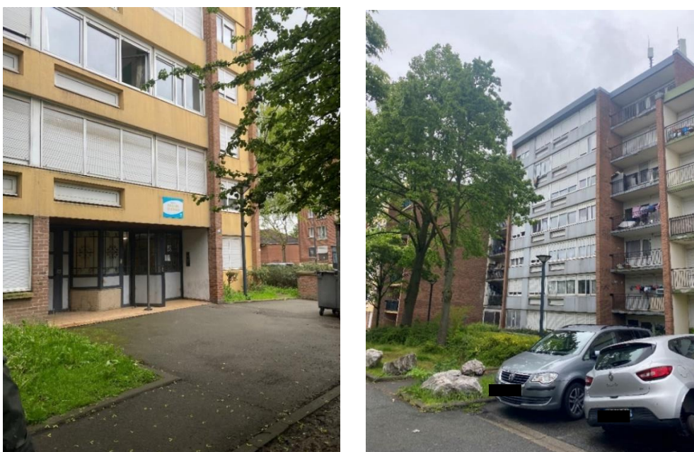
Figure 6 : Photos de 2 bâtiments de la résidence magasins généraux (source : Elise Firmin)
