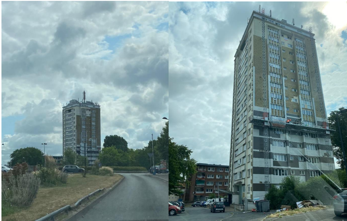
Figure 13 : Photo de la résidence Quai de Marseille pendant la réhabilitation (source : Elise Firmin)
