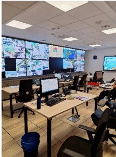
Figure 9 : Salle opérationnelle du PCC Cannois
