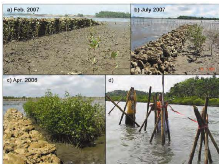
Figure 18: a), b) et c) digues de rochers à Ermita, Dumangas et Iloilo (2007-2008). d) support expérimental pour soutenir la croissance, diminuer l'énergie des vagues et piéger le sédiment (Winterwerp et al., 2020)
