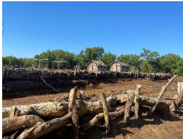
Image 1 : Mise en place d'une digue afin de protéger les habitations derrière la mangrove.
