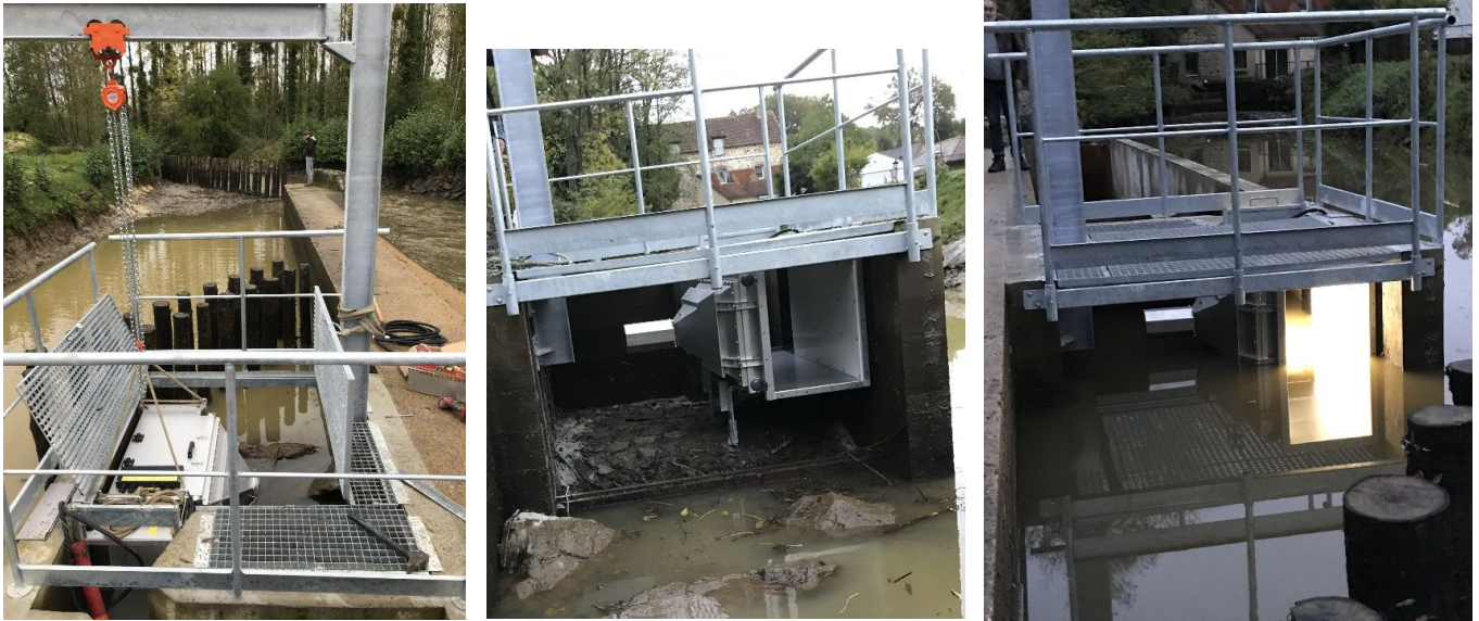
Figure 9 - Mise en place du Riverwatcher à l'entrée de la passe à poisson au Genest-Saint-Isle (@Syndicat JAVO)
