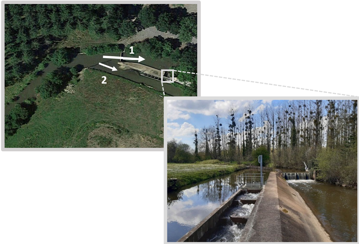
Figure 3 - La passe à poisson au moulin du Bas Coudray (@CANU Pao ; GoogleMaps®)
