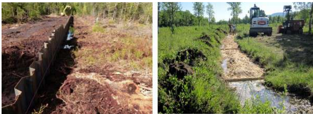
Figure 16 : La Neutralisation de drains - Tourbière du Forbonnet. Source : Programme Life Jura.
