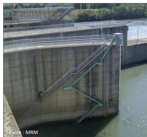
Figure 14 : Rampe à anguilles en RD de la centrale d'Avignon
