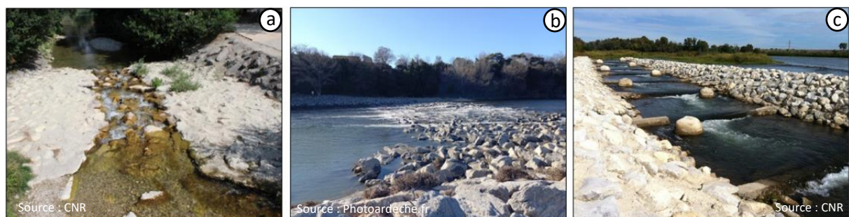
Figure 15 : les différents types de passes rustiques de la CNR. a) Echancrure sur le seuil du flon, b) Macrorugosité sur le seuil de l'Ardèche, et c) Rampe sur le seuil des Comps (Gard)
