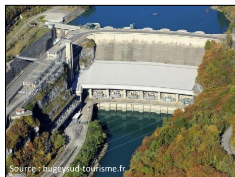
Figure 8 : Le barrage-centrale de Génissiat
