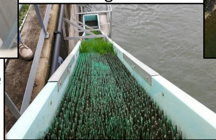
Passe à anguilles Rampe rugueuse pour la reptation de l'anguille
