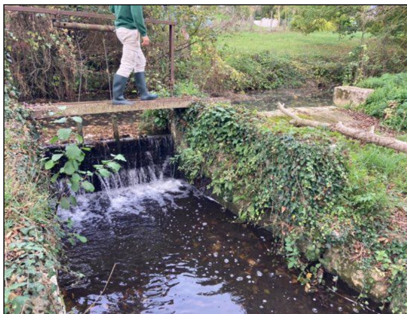
Figure 7.4.1 : Vanne du Grand Moulin (© A. Rougeyres)
