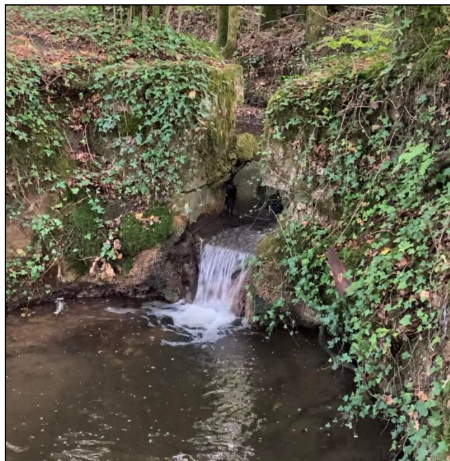
Figure 7.4.3 : Obstacle infranchissable du Petit Moulin (© A. Rougeyres)
