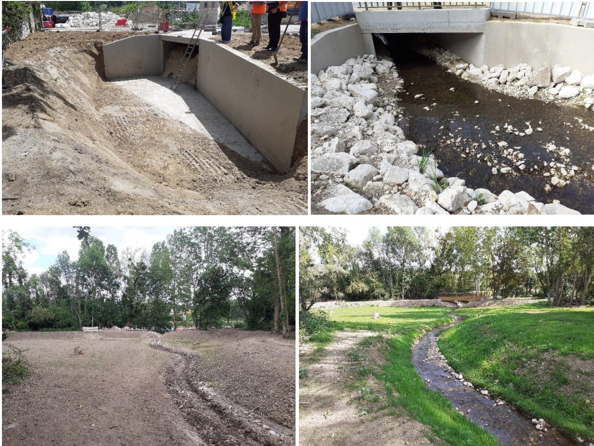
Figure 2: Illustrations de l'ouvrage de franchissement nouvellement créé et de la partie aval du ru du Bicheret (juin 2022 – juillet 2022)
