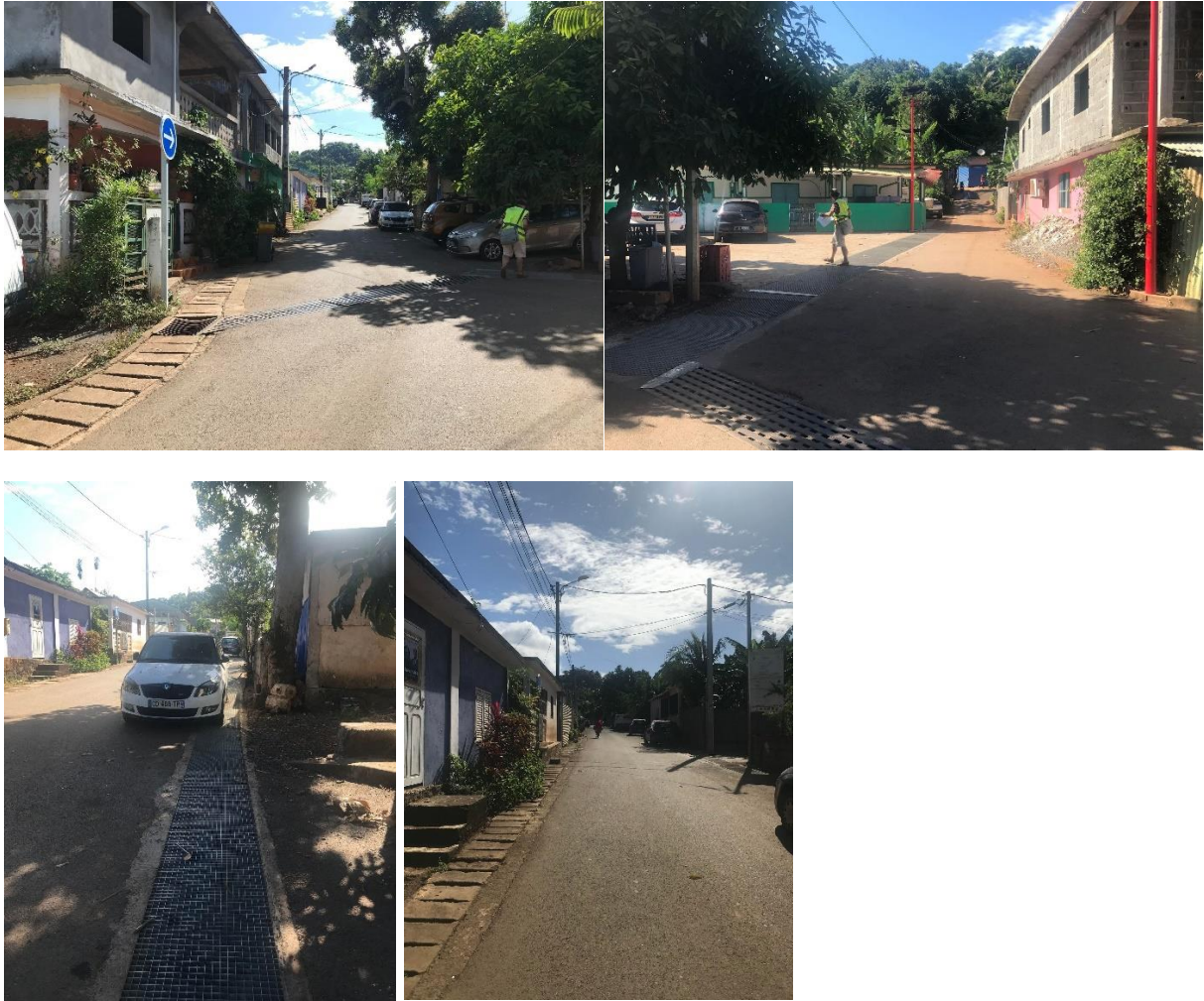
Figure 3 : Photographies de la partie Est de la boucle Rue de la Providence
