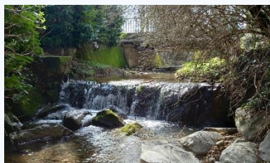
Figure 2 : Seuil maçonné - Girand (38) (Source: F. PEGUIN)
