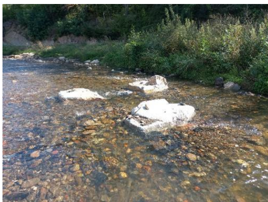
Figure 14 : Blocs de diversification des écoulements (Source : F. PEGUIN)
