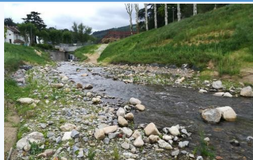
Figure 9 : Seuil de fond en blocs - Saint-Chamond (42) (Source : F. PEGUIN)
