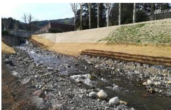
Figure 13 : Seuil de fond en blocs surmontés de techniques végétales, immédiatement après travaux - Saint-Chamond (42) - (Source : F. PEGUIN)
