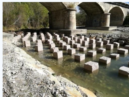
Figure 10 : Rampe en enrochements (Source : F. PEGUIN)
