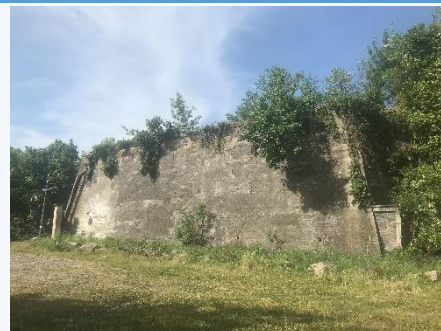
Figure 19 : Remblai ferroviaire à effacer - (Source : S. KREMER)
