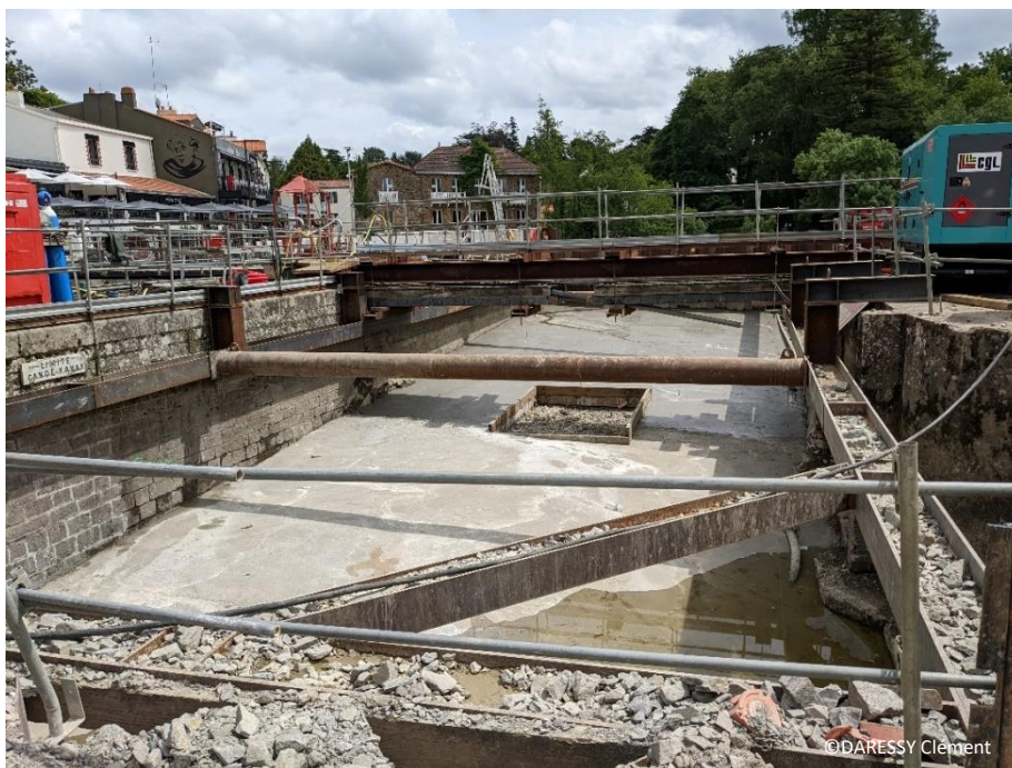
Figure 12 : Photo de la passe à poisson à Vertou
