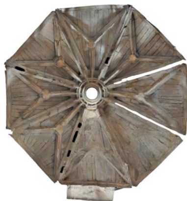
Orthophotographie de la voûte au dernier niveau de la tour d'escalier
