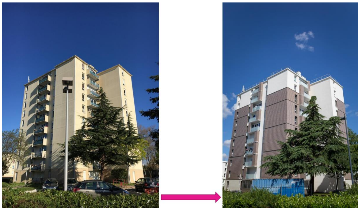
Figure 12 : Résidence Les Landes, Avant-après les travaux
