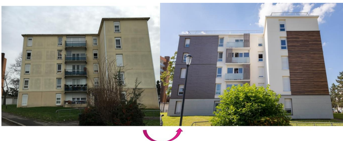
Figure 13 : Résidence Les Landes, Avant-après les travaux
