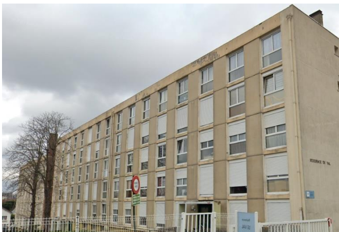
Figure 8 : Résidence Le Val, Bezons, avant les travaux
