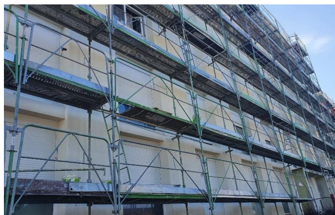
Figure 9 : Résidence Le Val, Bezons, pendant les travaux
