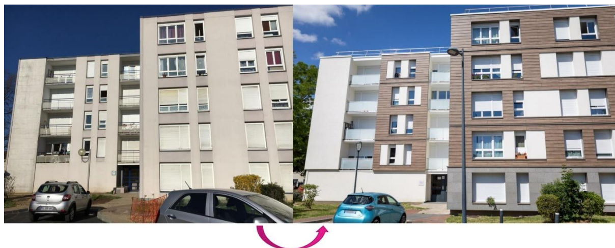
Figure 11 : Résidence Les Landes, Avant-après les travaux
