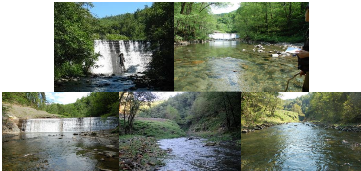
Figure 6 : Photographies de l'évolution de l'arasement du barrage Inturia
