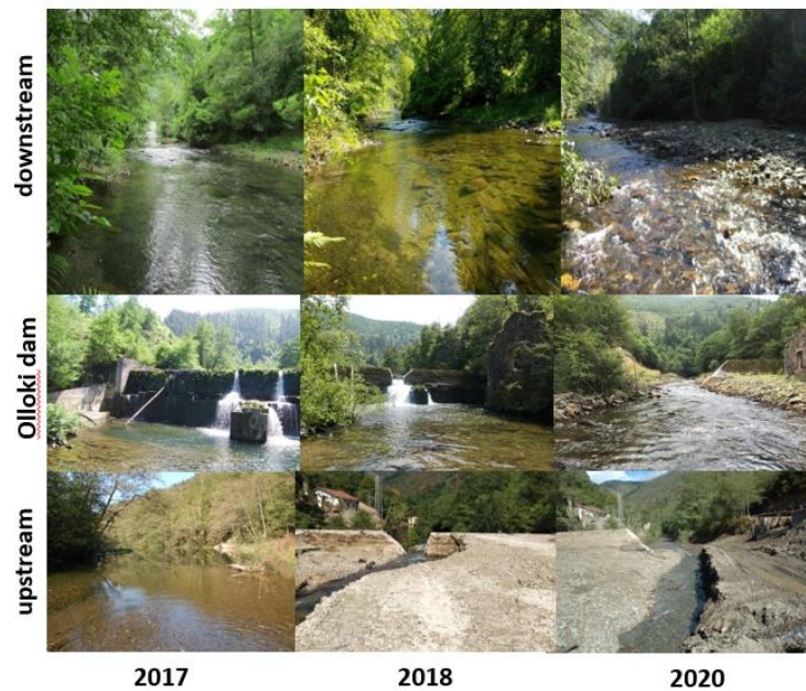
Figure 5 : Photographies de l'évolution de l'arasement du barrage Olloki (Askoa Ibisate)
