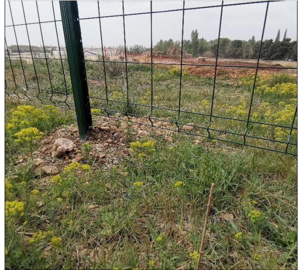
Clôture à 10 cm du sol pour passage de la faune
