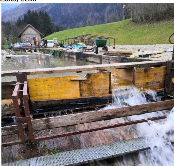
Figure 18 : Installation à l'exutoire du chenal pour le calcul des débits réels et l'estimation des pertes
