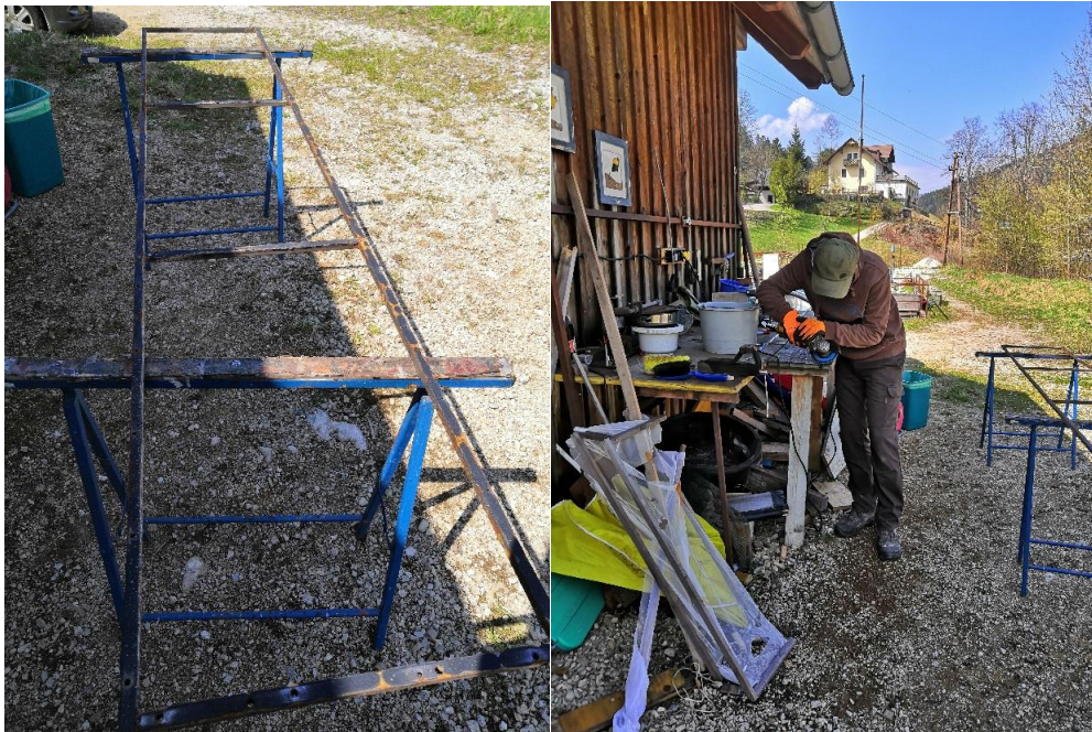
Figure 9 et 10 : Les cadres anciens et rouillés ont dû être rénovés à la meuleuse
