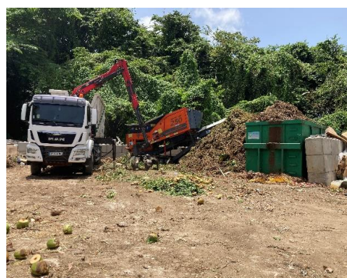
Figure 18 : Broyeur et benne à végétaux de la déchetterie de Jarry (Anna Brunerie)
