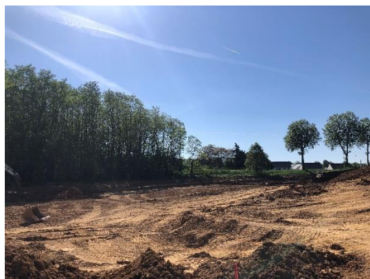
Figure 22 : Réalisation d'un bassin de rétention d'eau à Monnaie
