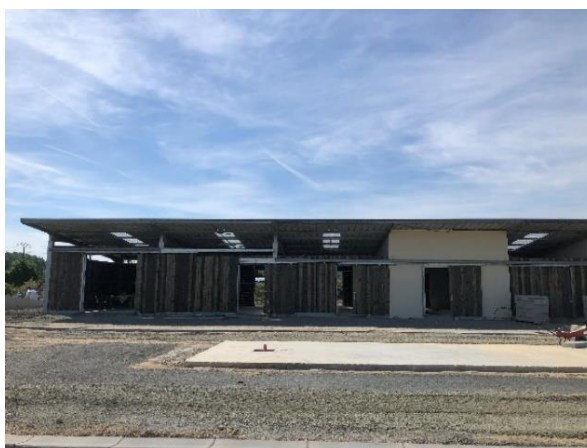
Figure 23 : Construction d'une déchèterie à Descartes
