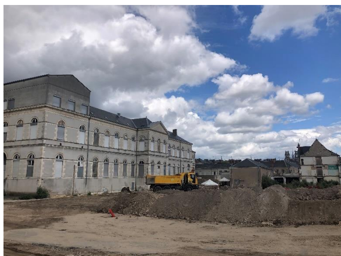
Figure 17 : Chantier de la ZAC Carmes Madeleine
