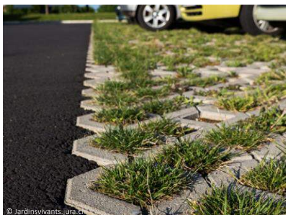
Places de stationnements en dalles alvéolées enherbées
