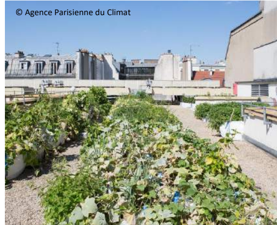
Toiture végétalisée semi-intensive – Paris
