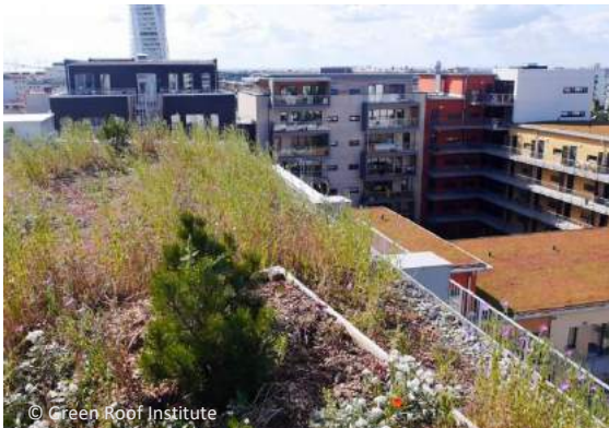
Toiture végétalisée semi-intensive – Malmö
