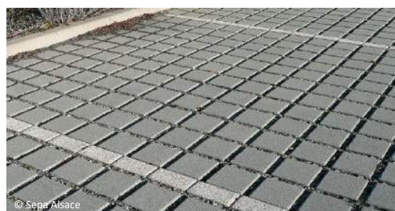
Places de stationnement en pavé à joints gravillonnés
