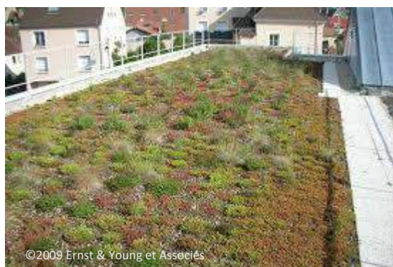
Toiture végétalisée extensive – Les Mureaux
