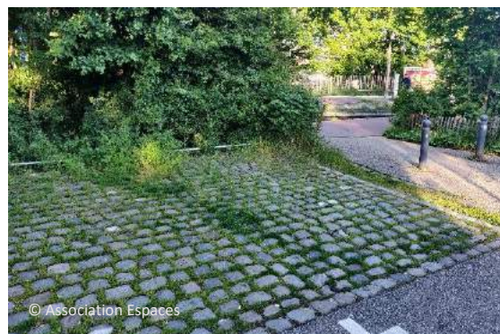
Places de stationnements en pavés avec joints engazonnés – Sèvres
