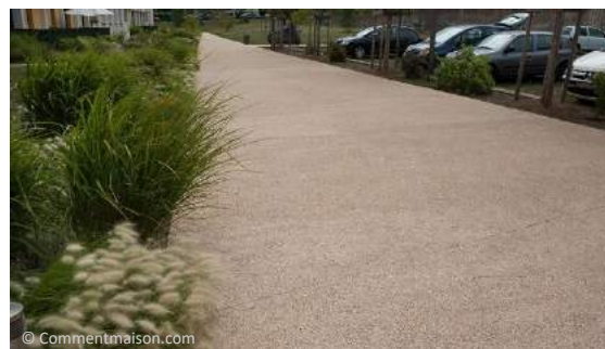
Voie piétonne en béton drainant
