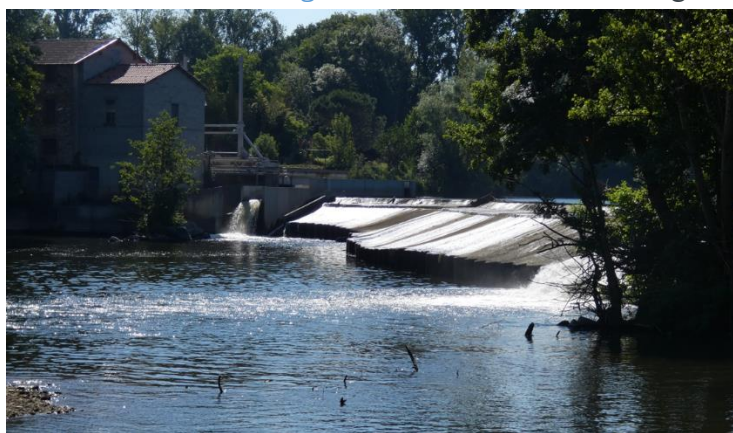
Photographie du seuil de la centrale hydroélectrique de Saint-Paul-Cap-de-Joux
