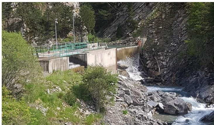
Figure 14 : Retenue d'eau de la centrale hydroélectrique de Meyronnes Auteur : Angel Neuenschwander
